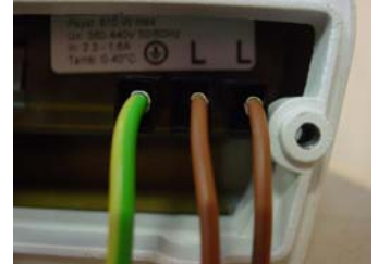
Aansluitdraden bevestigen op armatuur
